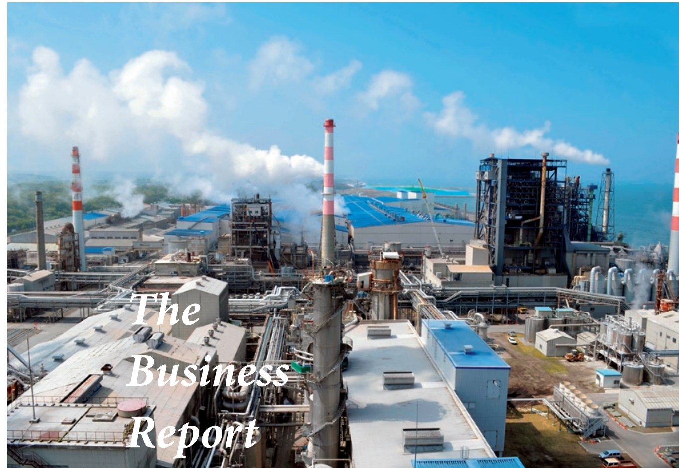
八戸工場（平成24年5月撮影）
